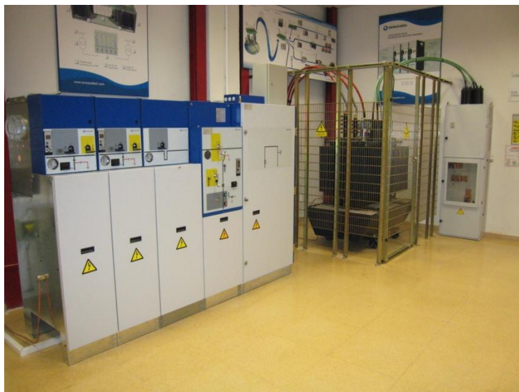
Vista de parte del Aula estado actual
